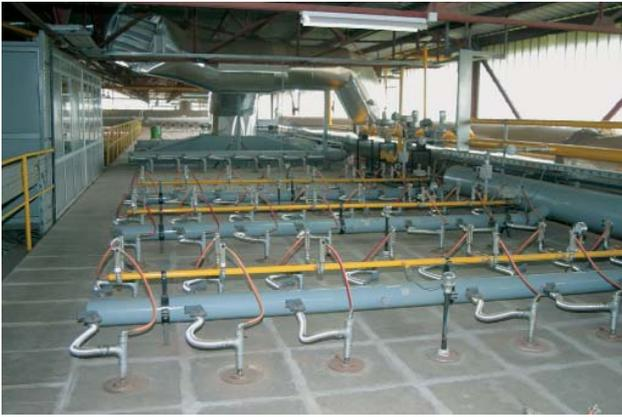
**Bild 7: Neue obere Absaugung in der Kühlzone**
