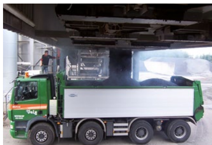
Асфальтовые и бетонные заводы
