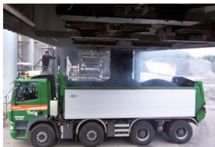
Planta de asfalto y/o hormigón
