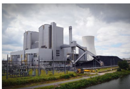
Planta de generación
