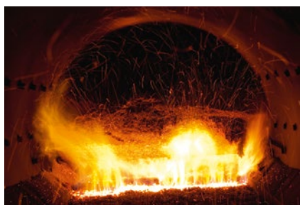
Planta de incineración
