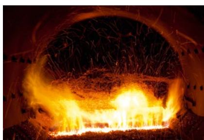
Planta de incineración
