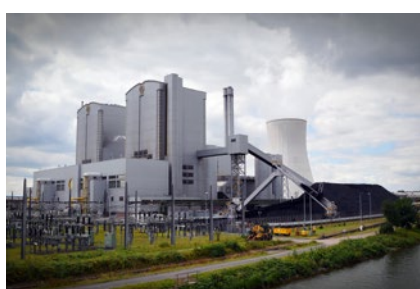
Planta de generación
