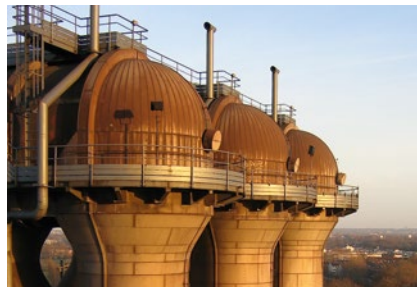
Haut fourneau / récupérateur Cowper
