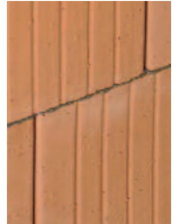
Nahezu fugenloses Mauerwerk
