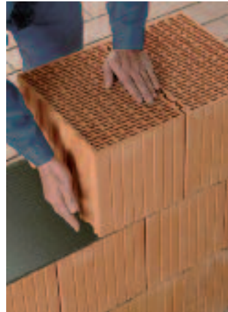
Versetzen der Ziegelreihen
