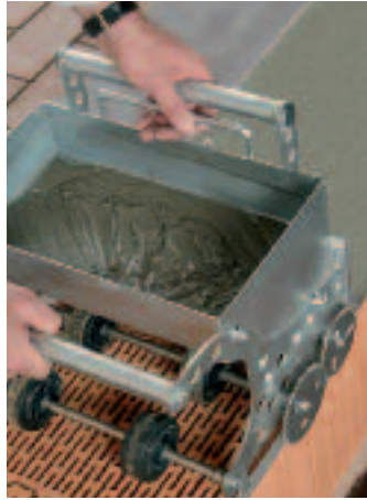
Auftragen des Mörtels
