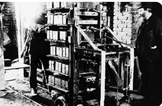
*Le chariot déposeur en phase d'essai. Au lieu de lattes ou de claies, on posait à la main des planches sur les bras du chariot déposeur. Ensuite, les briques étaient posées et poussées sur des rails dans les hangars de séchage.*
