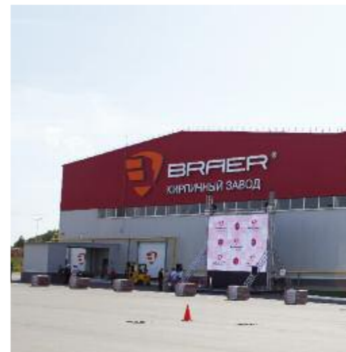
Производственная Halle des Ziegelwerks
