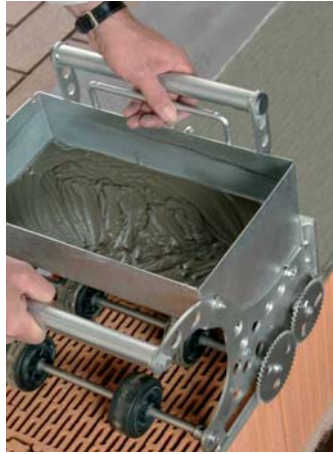
Auftragen des Mörtels
