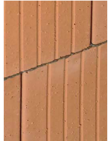
Nahezu fugenloses Mauerwerk
