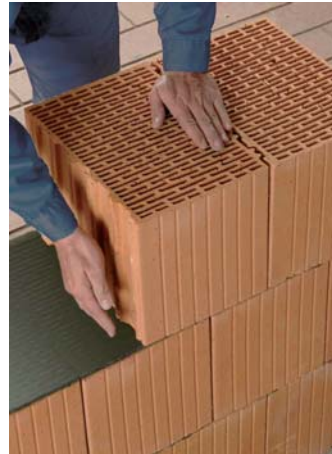
Versetzen der Ziegelreihen
