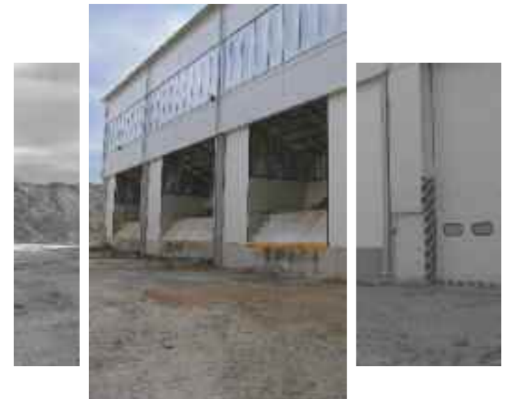
Aufgabekastenbeschicker im Bereich Rohmaterialaufgabe
