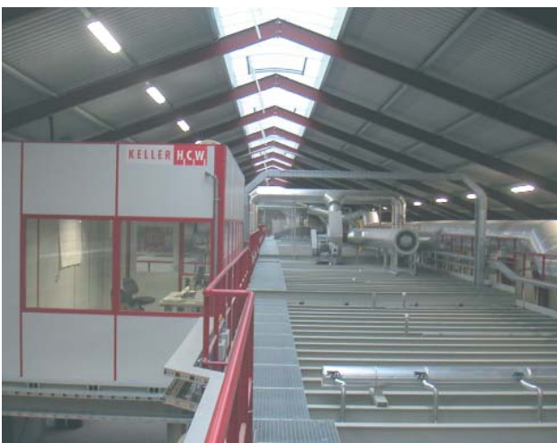
Bild 7: Schaltwarte und offenes Deckenträgersystem Fig. 7: Switch room and open ceiling girder system
