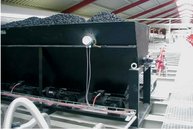
Bild 5: Bekohlungsanlage Fig. 5: Cooling plant
