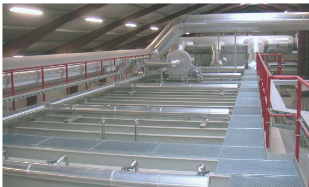
Bild 3: Deckeneinblasung über Crownjets Fig. 3: Ceiling injection via 'Crown jets'
