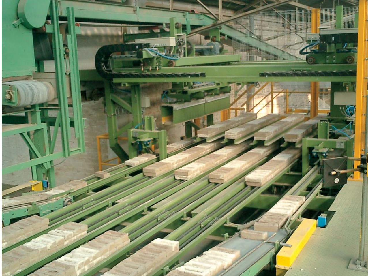
Bild 4: Einlaufbereich SM Fig. 4: Inlet area of setting machine
